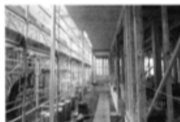
工事中の内部
