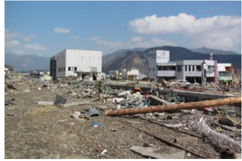
写真5 大船渡駅の津波被害
