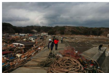
写真2 破壊された田老地区防潮堤 (元田良孝氏提供)
